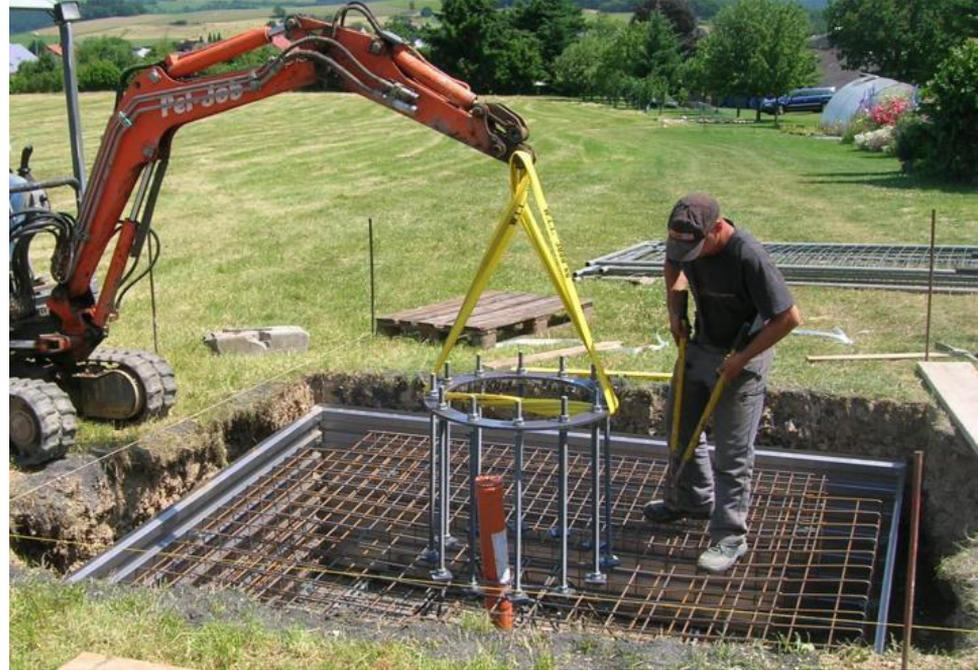
Abbildung 2: Montage des unteren Flansches (Ringanker) im Fundament mit dem innen liegenden Leerrohr für das Kabel zum Generatoranschluss.
