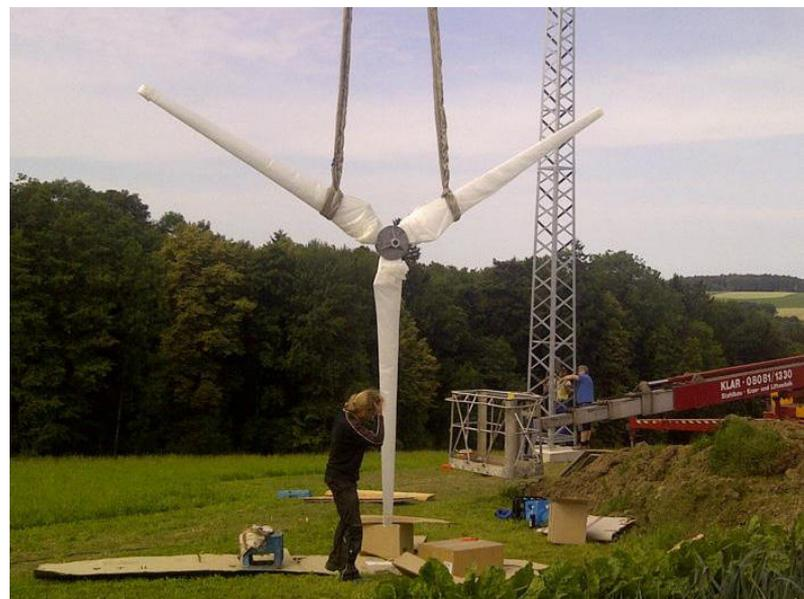
*Abbildung 7:* Vormontierter Rotor
