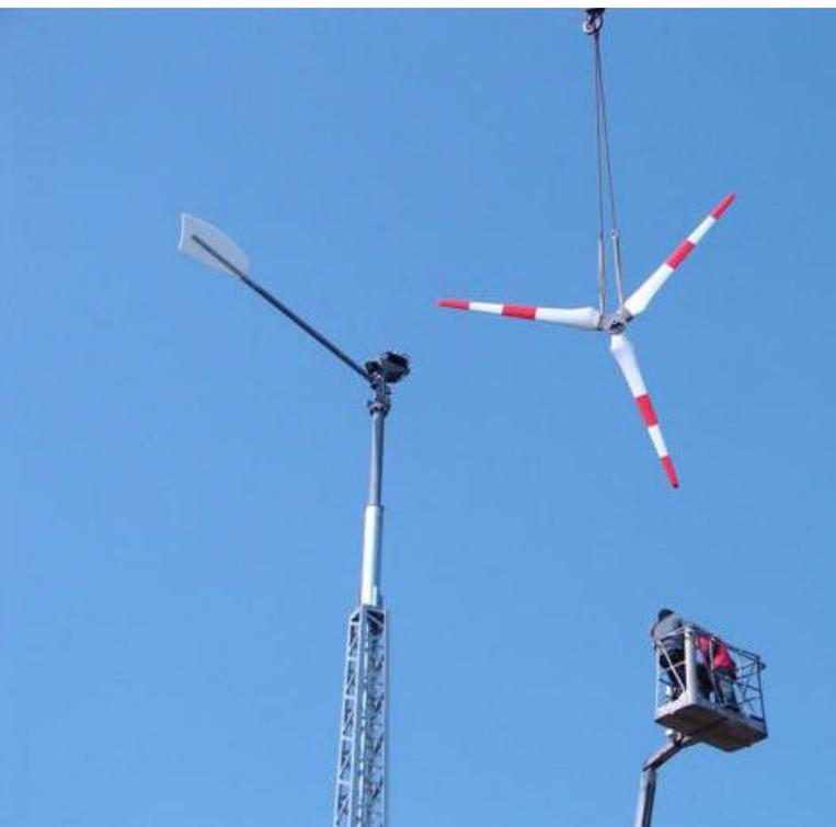
*Abbildung 8:* Getrennte Montage von Maschinenträger und Rotor auf einem freistehenden Masten mit Kran und Hebebühne. Bei ausreichender Traglast der Hebebühne können die Teile auch einzeln mit der Hebebühne zur Spitze des Masten transportiert werden.
