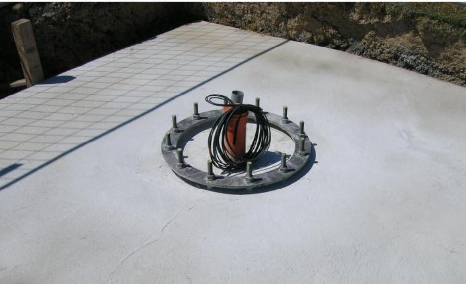
Abbildung 3: Fertiges Fundament mit den Schrauben für den Mast und dem Leerrohr mit der Generatorzuleitung.
